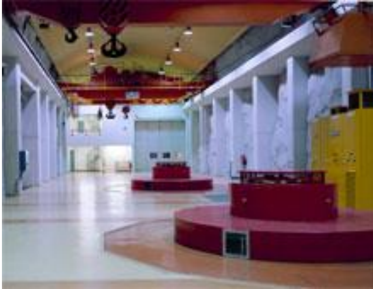
Mynd 19. Stöðvarhúshvelfing Blönduvirkjunar.
