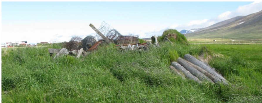
Mynd 18, horft til norðurs yfir leifar fjárhúsa (nr. 53) skammt norður af Hrafná.
